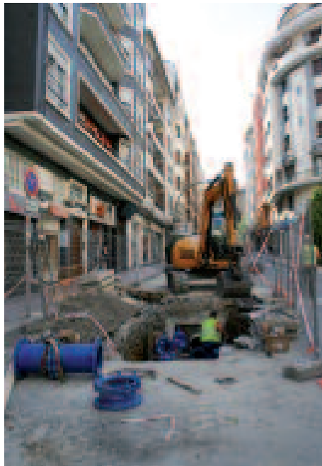
Bidebarrietan, herriko beste kale askotan bezala, uraren kanalizazioarako hodi berriak ipintzen dihardute.
